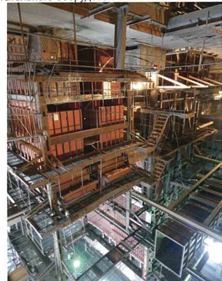
На фото: Ведутся работы на котлоагрегате ст. №1
