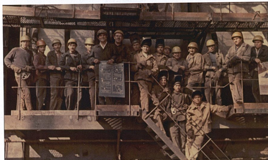
На фото: Бригада монтажников Журба Михаила
