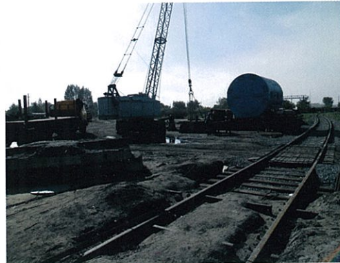
Транспортировка генератора
