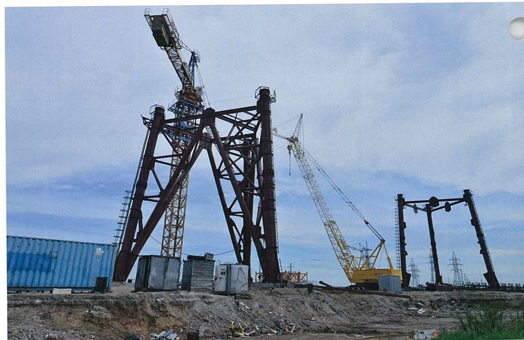
Основания каркаса дымовых труб №1,№2 ТЭЦ-3 г.Астана
