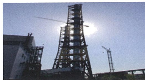
Фото: 2011 год. Монтаж стелов и каркасов дымовых труб водогрейной котельной ТЭЦ-2
