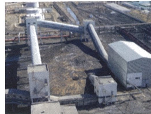
Фото 2009 год Реконструкция тракта топливоподачи ТЭЦ-1
