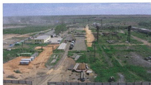
Фото: 2004 год. Территория стройдвора на ТЭЦ-2
