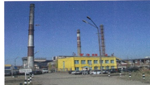
Фото 2008 год. Начало реализации проекта на ТЭЦ-1
