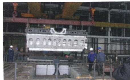
Фото: 2005 год Монтаж ЦНД ТГ-4 ТЭЦ-2
