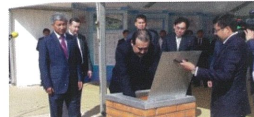
Фото: 2010 год. Премьер-министр РК К. Масимов заложил капсулу в основание строительства ТЭЦ-3.
