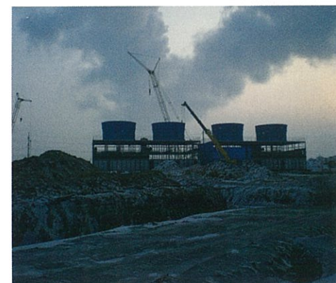
На фото: ведется монтаж вентиляторных градирен №1-2
