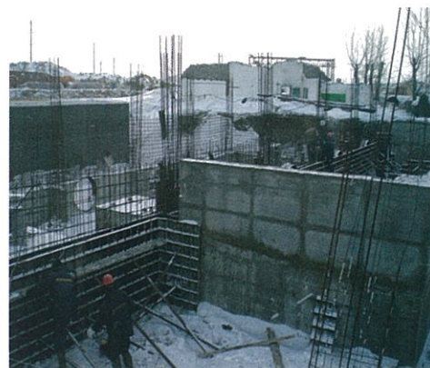
На фото: Ведется монтаж циркуляционной
