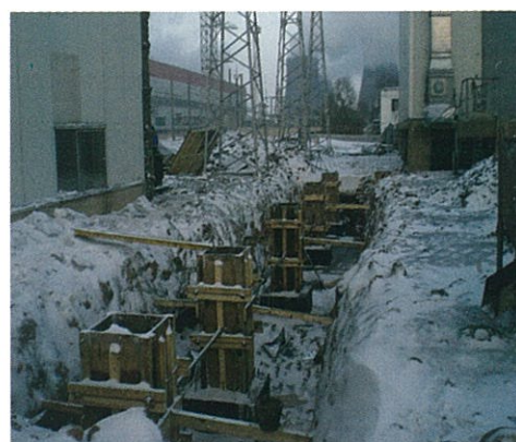
На фото: ведется монтаж эстакад кабельного хозяйства пристанционного узла, расширяемой части ТЭЦ-2 г. Астана. Кабельная эстакада соединяющая КРУЭ 220 кВ. и релейный щит. Бетонирование фундаментов
