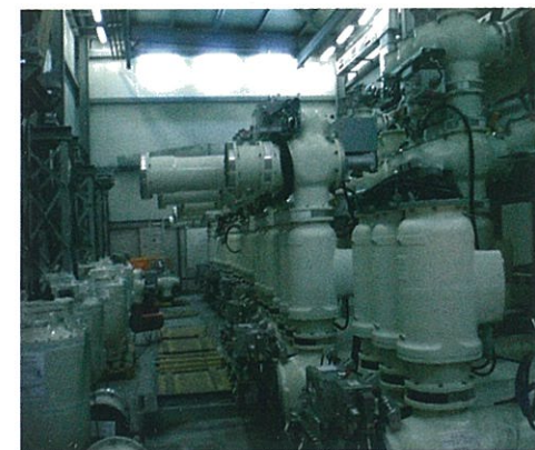
На фото: Ведется монтаж оборудования КРУЭ 220 кВ.
