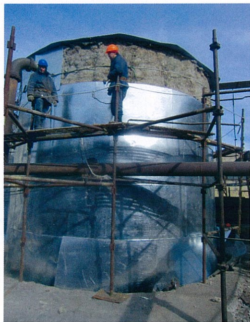
На снимке: звено изоляторов Иманбаев С.Н., Слабодчиков И.П. производит покрытие поверхности изоляции емкости Химического цеха ТЭЦ-3.
